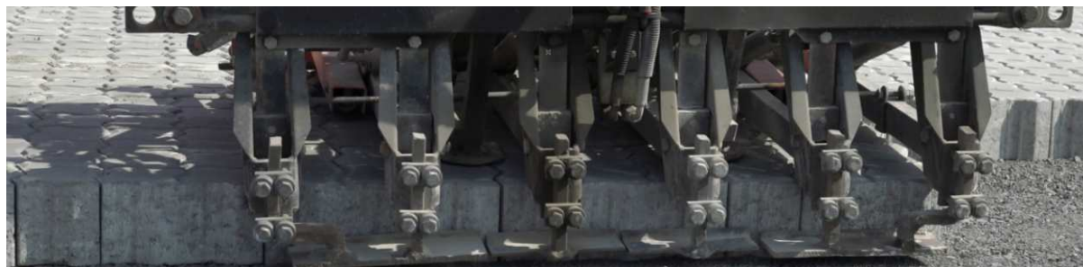
Укладання дорожньої бруківки
